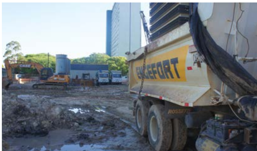
Atividades suspensas no canteiro da Engefert
